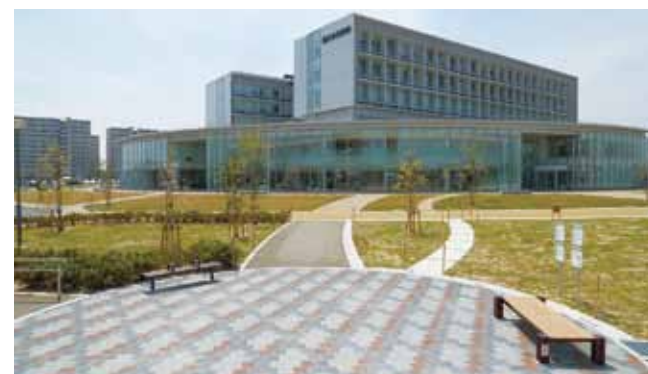
▲施工実績：文化の丘公園(愛知県稲沢市)
