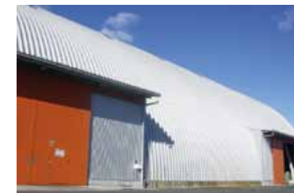
▲南栄工場（プラスチックリサイクル）
