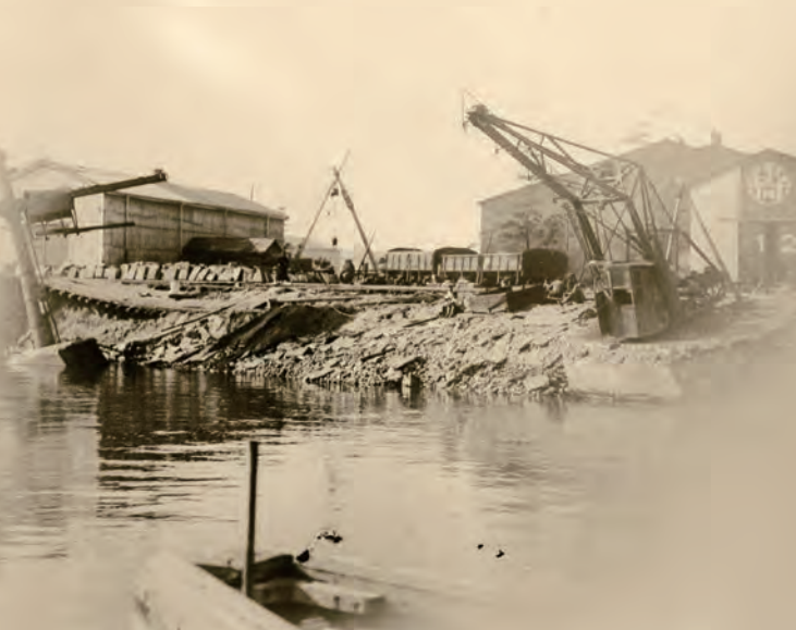
名古屋港の昭和東南海地震被災状況
