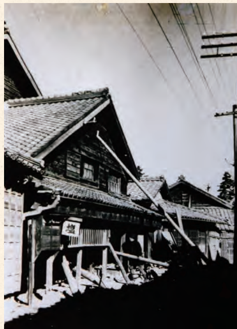
昭和東南海地震で被災した建物(現在の碧南市内) 撮影:原田三郎さん
