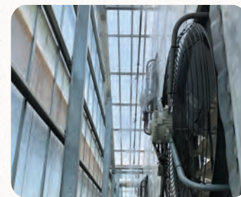
◀ハウス1棟につき3台の換気扇を設置し、強制的に気流を生み出している
