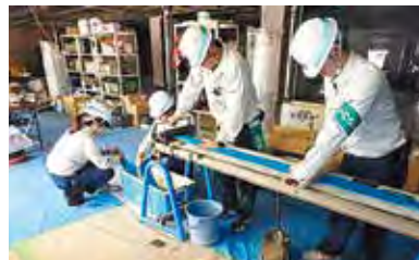
◀FRPライニングは建造物に手を加えることなく更生させることができるため、歴史的建造物にも採用された実績を持つ
