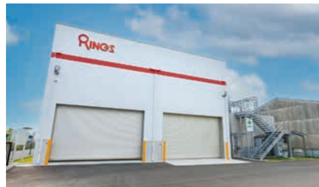
▲2024年4月より運用開始した中間処理施設。施設の運用はグループ会社である株式会社リングスが行う
