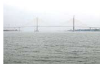
メコン川に架かるネアックルン橋
