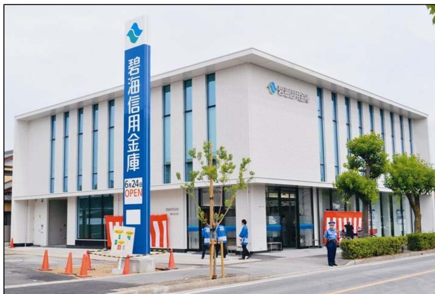
刈谷北支店 平成25年6月24日新築オープン 〔刈谷市高倉町1丁目207番地〕
