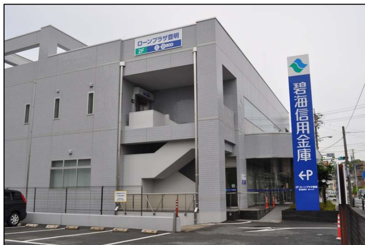
ローンプラザ豊明〔豊明支店2階〕 平成25年7月1日オープン
