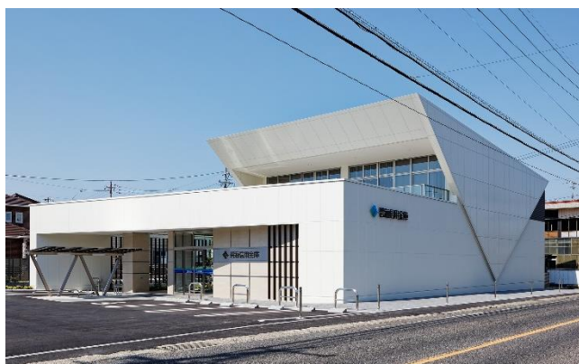
豊田西支店・豊田朝日支店 新築移転オープン（5月7日）
